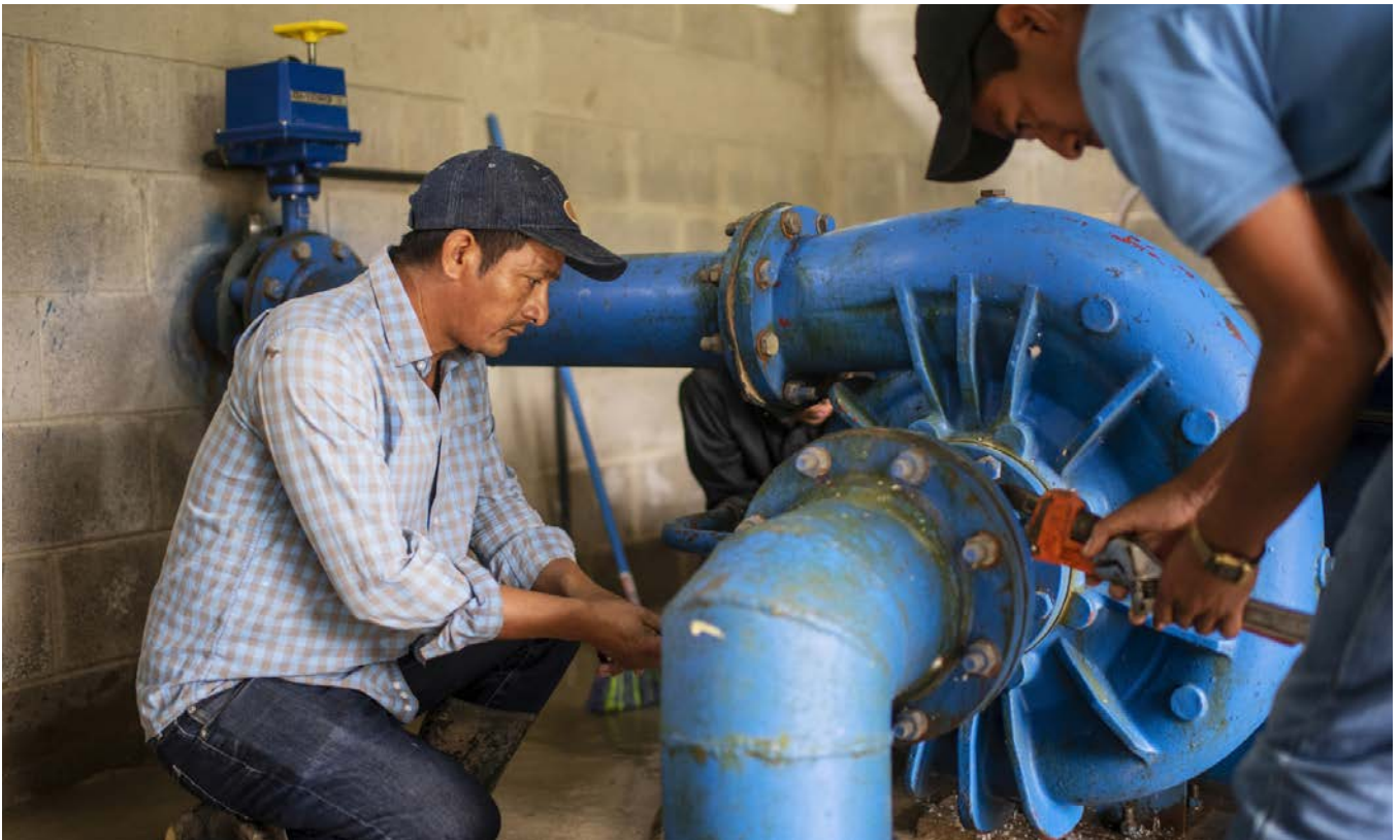
Hartes Stück Arbeit Bevor die Bewohner von La Gloria ihre Turbine anschließen konnten, mussten sie viele Hindernisse überwinden.
