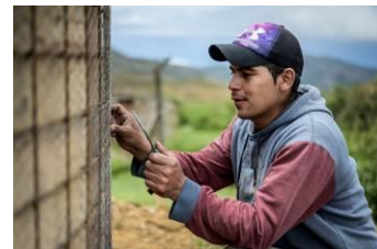
Sorgt vor Kleinbauer David Velázquez lebt 800 Meter oberhalb der nächsten Wasserstelle. Deswegen baut er nun einen Wasserspeicher.
