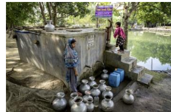
Zuverlässige Reinigung Die von CCDB installierte Anlage filtert das Wasser mittels Kies und Sand.
